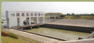
為減少東江水運送到香港途中受污染的機會，廣東省政府將東江取水口上移至水質較佳的地方，並興建由泵站、高架渡槽、隧洞、水庫和專用導管組成的輸水系統，直接將東江原水輸送至深圳水庫。
